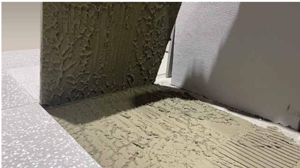
Para liberação ao tráfego, verificar informações especificadas pelo fabricante da argamassa. O mau assentamento e/ou liberação ao tráfego antes do prazo recomendado podem levar ao aparecimento de fissuras e o descolamento do produto. É imprescindível proteger o piso após o assentamento e a limpeza. Utilizar plástico limpo (nunca utilizar papelão, pois este pode absorver umidade e eventualmente manchar as peças).
