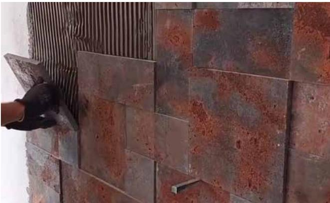
Aplicar cada peça aproximadamente 3cm fora da posição final, em seguida pressioná-la, arrastando-a perpendicularmente aos cordões, até a sua posição final. Atendida a posição final, aplicar vibrações manuais de grande frequência, transmitidas pela marreta de borracha previamente protegida, procurando obter a maior acomodação possível, que pode ser constatada quando a argamassa colante fluir pelas bordas da placa.
