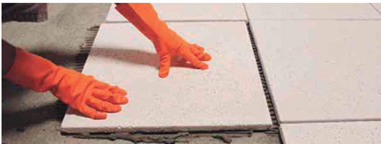
A placa já com a argamassa colante aplicada em seu verso com os cordões formados, deve ser posicionada na mesma direção dos cordões de argamassa aplicada no contrapiso. Os cordões de argamassa devem estar retos, tanto no verso da peça quanto no contrapiso.
